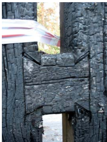
Zwęglone ciesielskie połączenie w słupku podcienia
